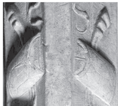
Fig. 19 : Travee VIIa, gros contrefort*
